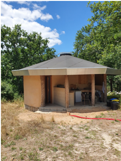
Sanitair gebouw met buiten- Keuken voor kampeers
